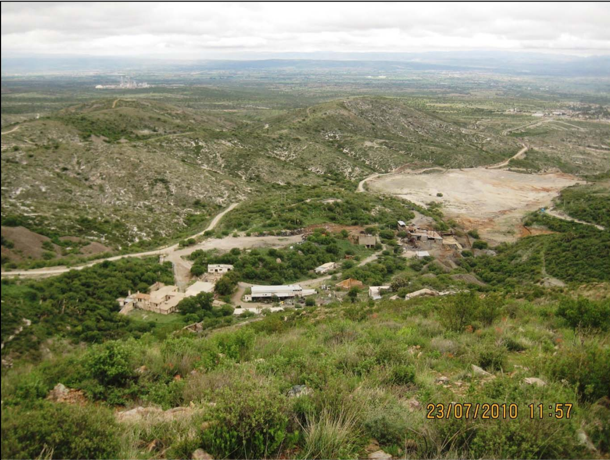
Planta de beneficio San Pedro, ubicada dentro del distrito minero Tepezala-Asientos, pertenece a la compañía minera Real de Ángeles, S.A. de C.V.; actualmente se encuentra inactiva
