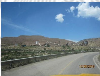
Quebradoras El Porvenir
