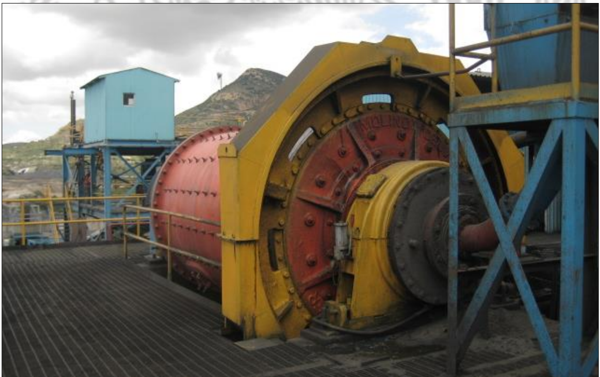
Molino "SAG-Semiautogeno" de la planta Santa Francisca
