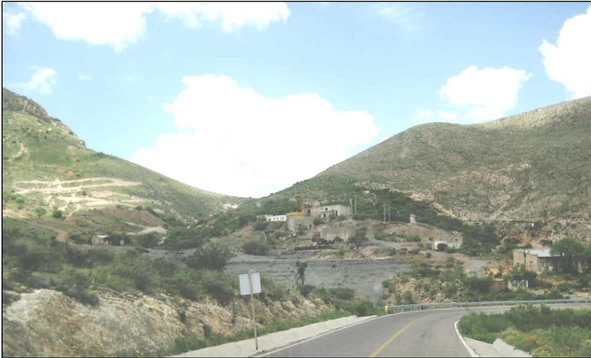
Planta de beneficio Minerva, ubicada dentro del distrito minero Tepezalá-Asientos, pertenece a la compañía minera Real de Ángeles, S.A. de C.V., del Grupo Frisco, S.A. de C.V.; actualmente inactiva.
