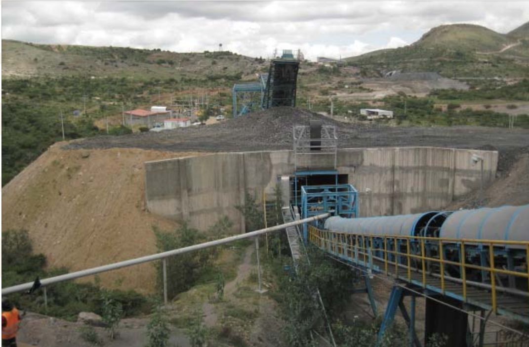
Detalle de la banda principal de la planta de beneficio Compañía Minera Real de Ángeles, S.A. de C.V. (Unidad Santa Francisca), Grupo Frisco, S.A. de C.V., municipio de Asientos, Ags.
