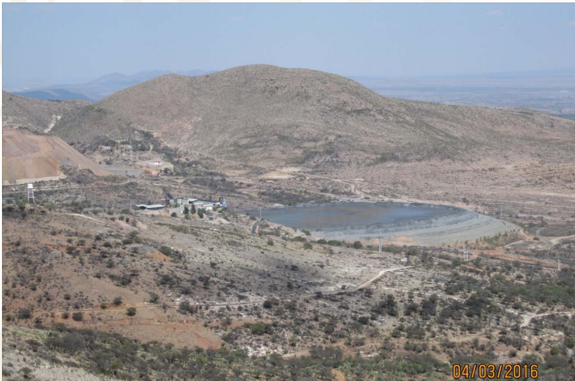
Planta de beneficio El Orito, ubicada dentro del distrito minero Tepezalá-Asientos, pertenece a la compañía minera Real de Ángeles, S.A. de C.V.
