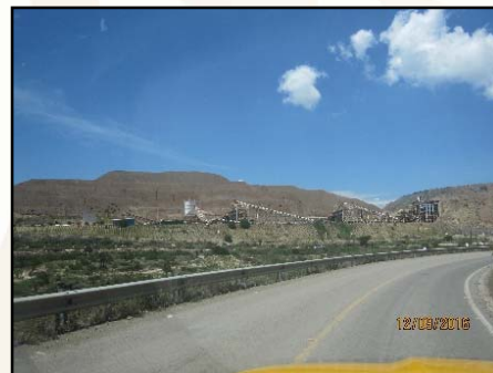
Quebradoras El Porvenir.
