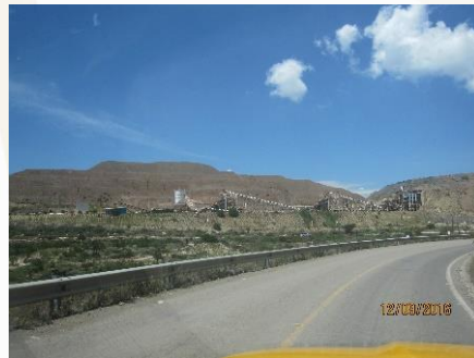
Quebradoras El Porvenir.
