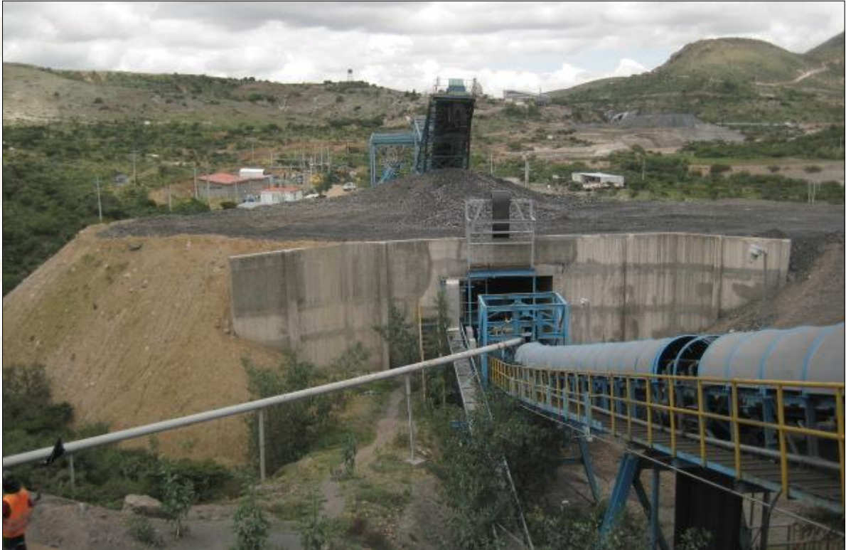
Detalle de la banda principal de la planta de beneficio Compañía Minera Real de Ángeles, S.A. de C.V. (Unidad Santa Francisca), Grupo Frisco, S.A. de C.V., municipio de Asientos, Ags.
