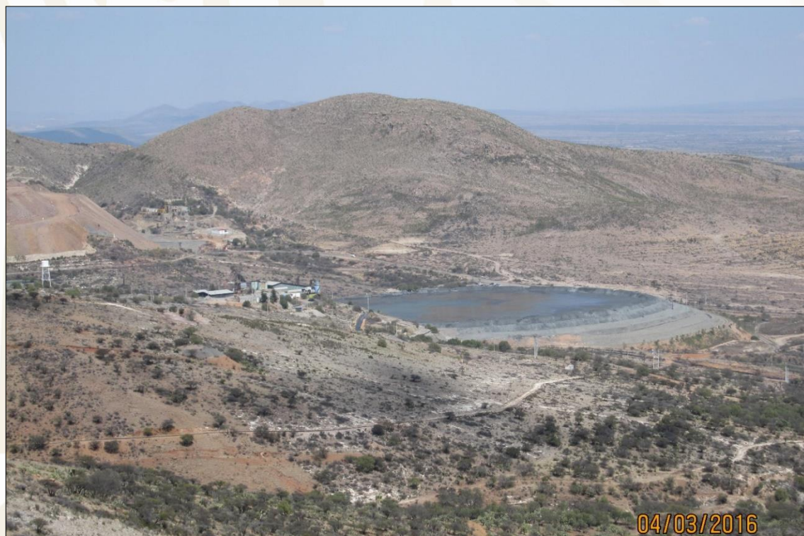
Mina y Planta de beneficio El Orito, ubicada dentro del distrito minero Tepezalá-Asientos, pertenece a la compañía minera Real de Ángeles, S.A. de C.V.
