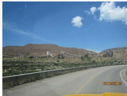
Quebradoras El Porvenir.
