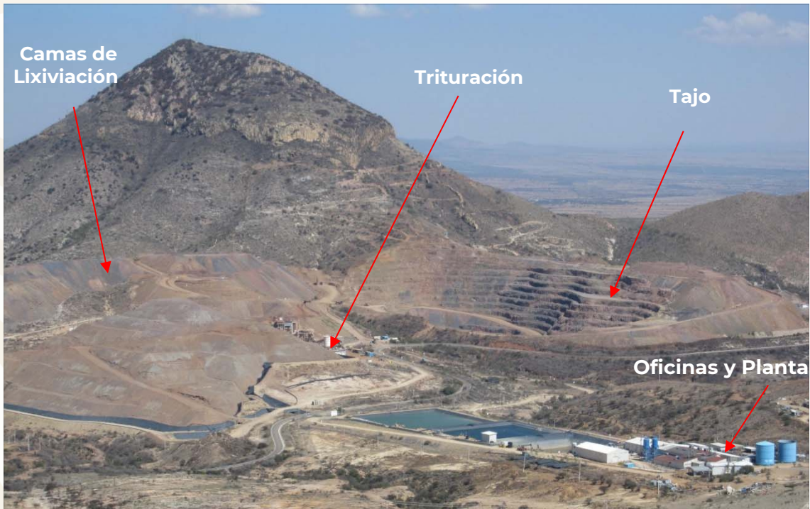
Panorámica del Tajo Abierto "El Porvenir" el cual se encuentra inactivo desde el primer trimestre del año 2019, debido a que se agotaron sus reservas de mineral por lo que ya no se esta explotando mineral para ser depositado en las camas de lixiviación (Reporte del primer trimestre 2019 - MINERA FRISCO).
