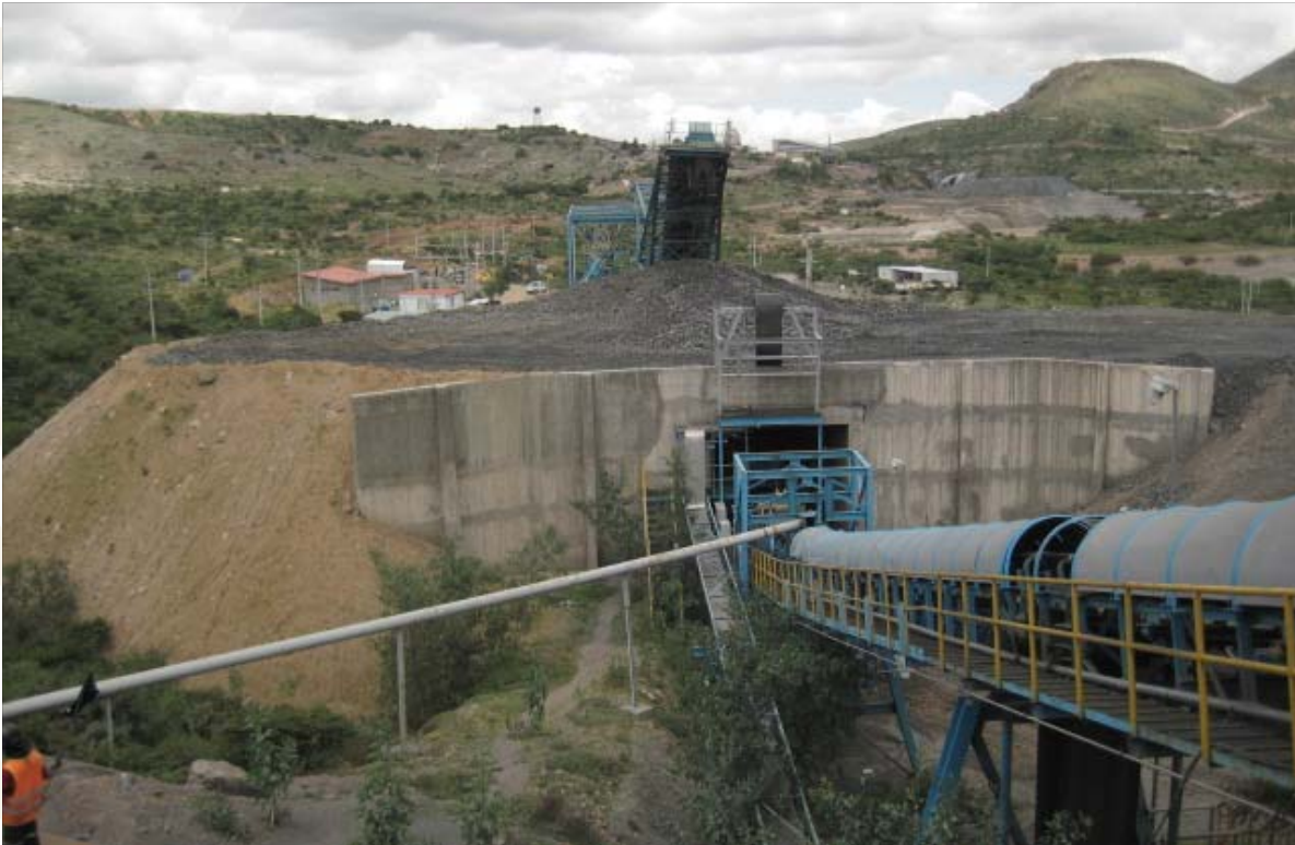
Detalle de la banda principal que alimenta a la planta de beneficio, Compañía Minera Real de Ángeles, S.A. de C.V. (Unidad Santa Francisca), Grupo Frisco, S.A. de C.V., municipio de Asientos, Ags.
