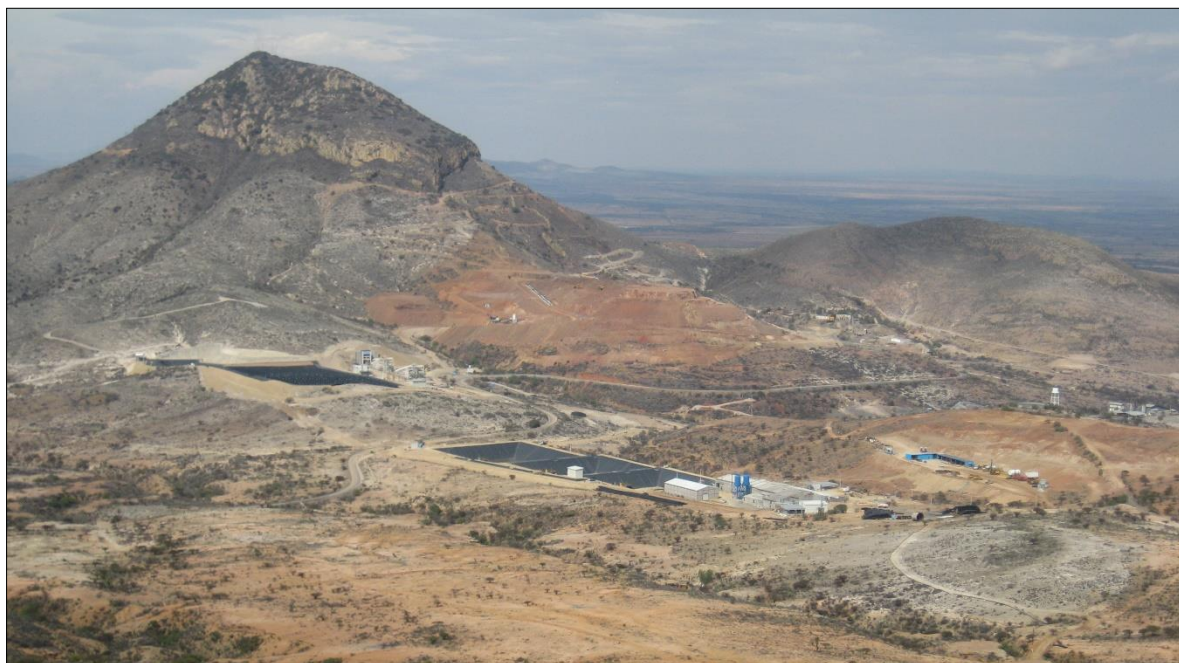
Panorámica Tajo El Porvenir del 21 febrero de 2012, se realiza la preparación del tajo abierto y la extracción del material y el proceso de lixiviación.
