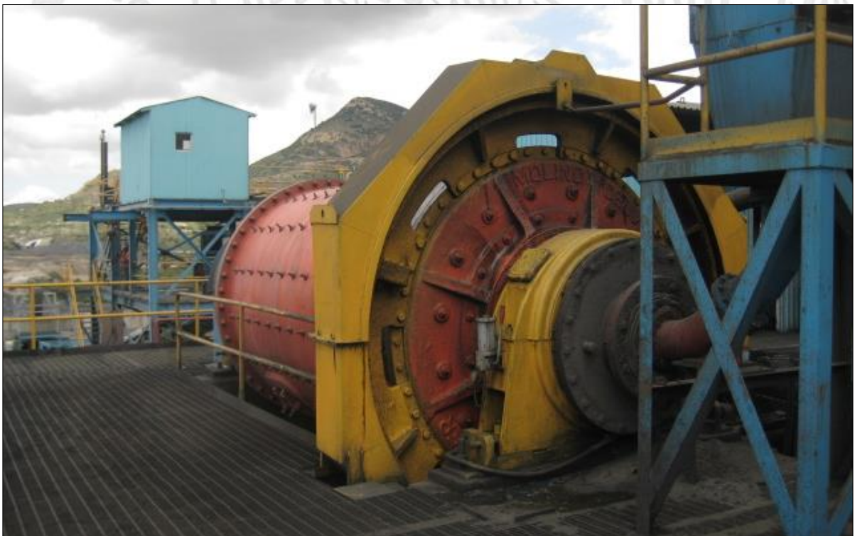
Molino "SAG-Semiautogeno " de la planta Santa Francisca
