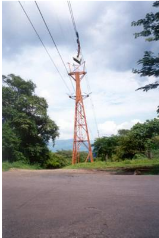
TELEFÉRICO QUE TRANSPORTA EL MINERAL DE LA MINA EL ENCINO A LA PLANTA PELETIZADORA DE ESTACIÓN ALZADA MPIO. DE CUAUHTÉMOC, COL. (EN RECESO)
