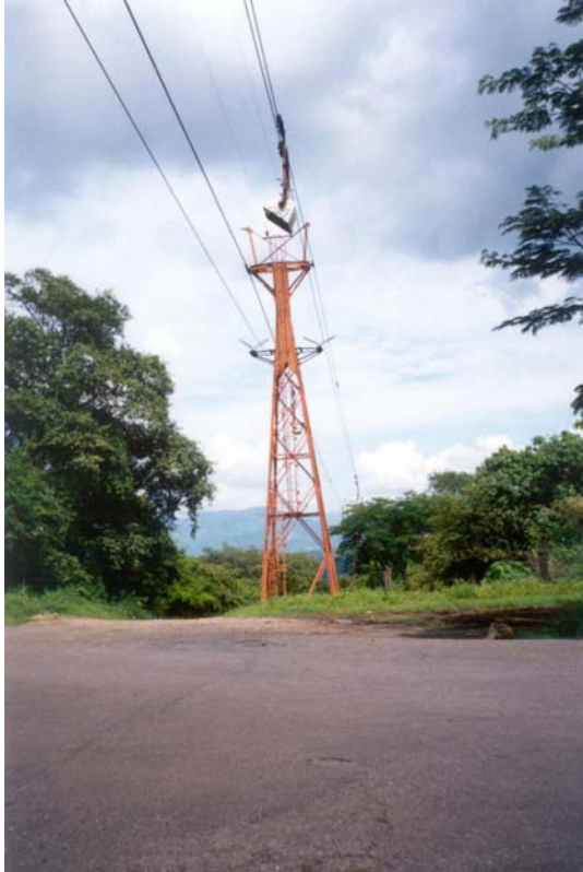
Teleférico que transporta el mineral de la mina El Encino a la planta peletizadora de Estación Alzada, Mpio. de Cuauhtémoc, Col. (En receso).
