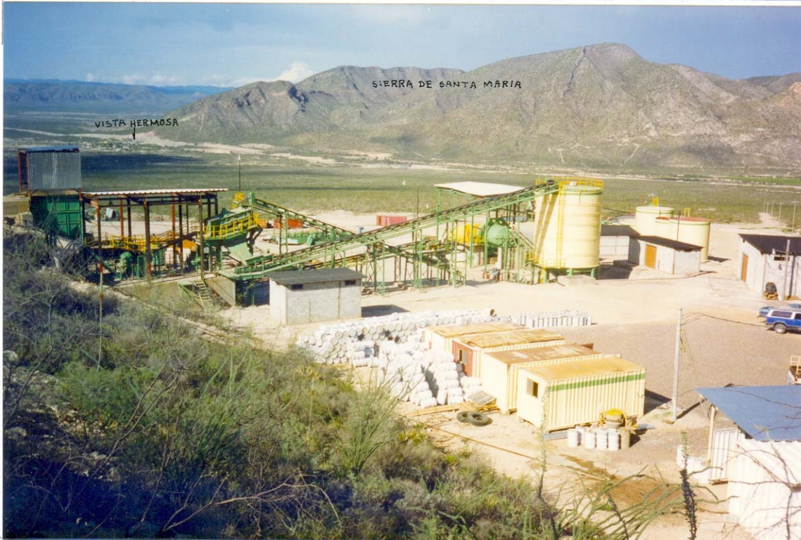
Panorámica de las instalaciones de la planta de beneficio, que actualmente esta en rehabilitación, por la empresa minera Peñoles, en el poblado de Velardeña.
