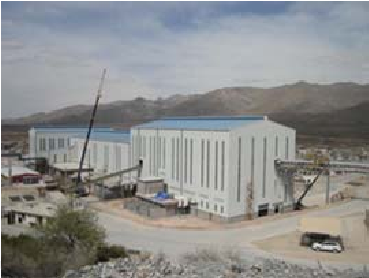
Planta de concentrados de plomo, cobre y zinc.
