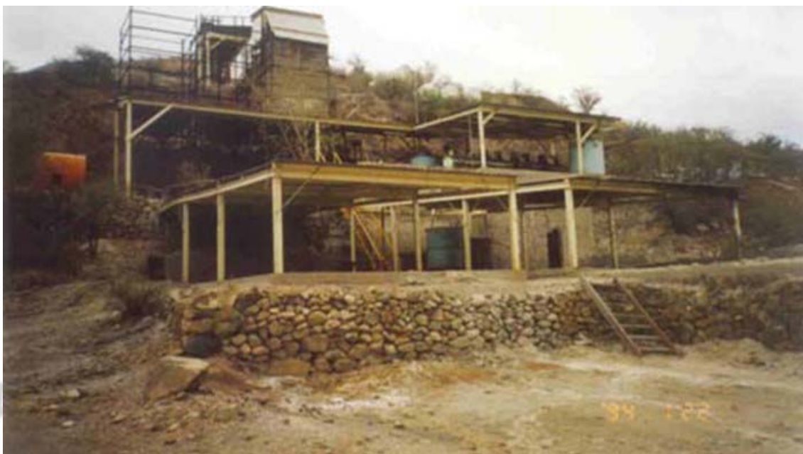
Planta de beneficio por flotación procesa mineral de Au, Ag, Pb, Zn. Con capacidad de 226 t/día.
