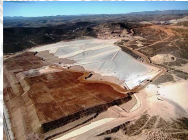
Panorámica donde se muestra patio de lixiviación de la mina El Castillo, Distrito Minero de San Juan del Río, Dgo.
