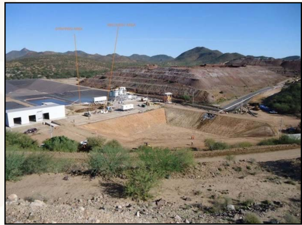
Panorámica donde se muestra patio de lixiviación de la mina El Castillo, Distrito Minero de San Juan del Río, Dgo.
