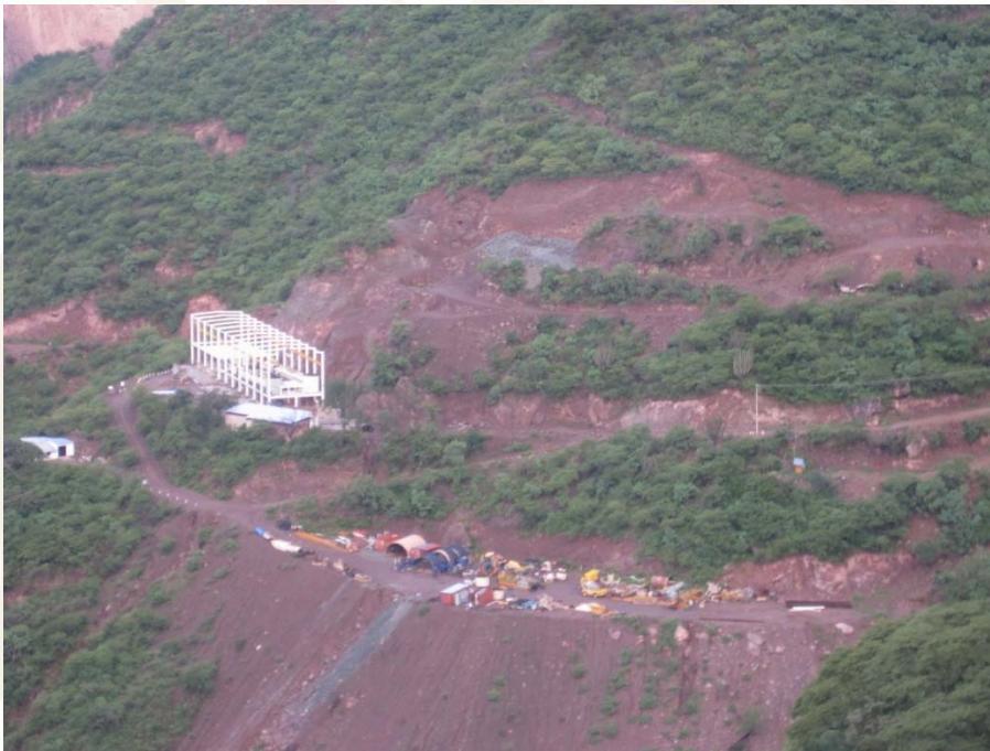
Panorámica de la planta de beneficio en construcción, capacidad de molienda proyectada de 1,000 t/d
