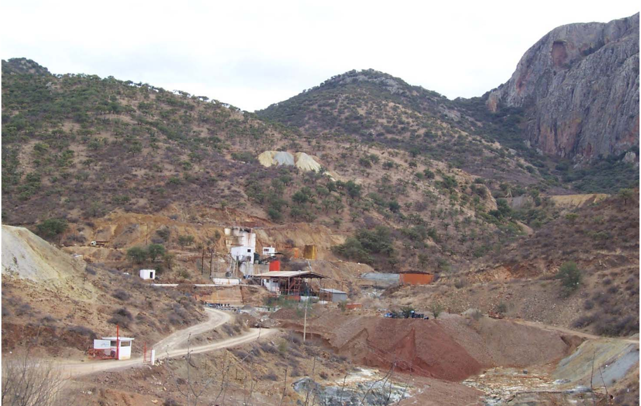
Instalaciones de la planta de beneficio, utilizadas para procesar el mineral de las minas del Distrito Minero Indé.
