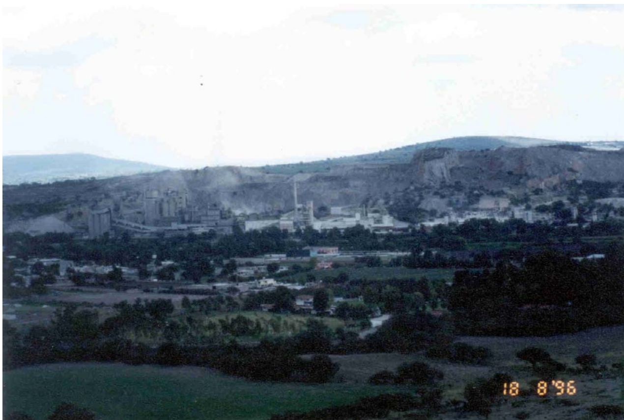
Vista general de la fábrica de Cementos Apasco, Mpio. de Apasco, Edo. de México.
