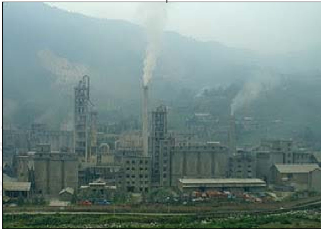
Fábrica de Cementos Holcim Apasco, en el municipio de Apaxco Estado de México
