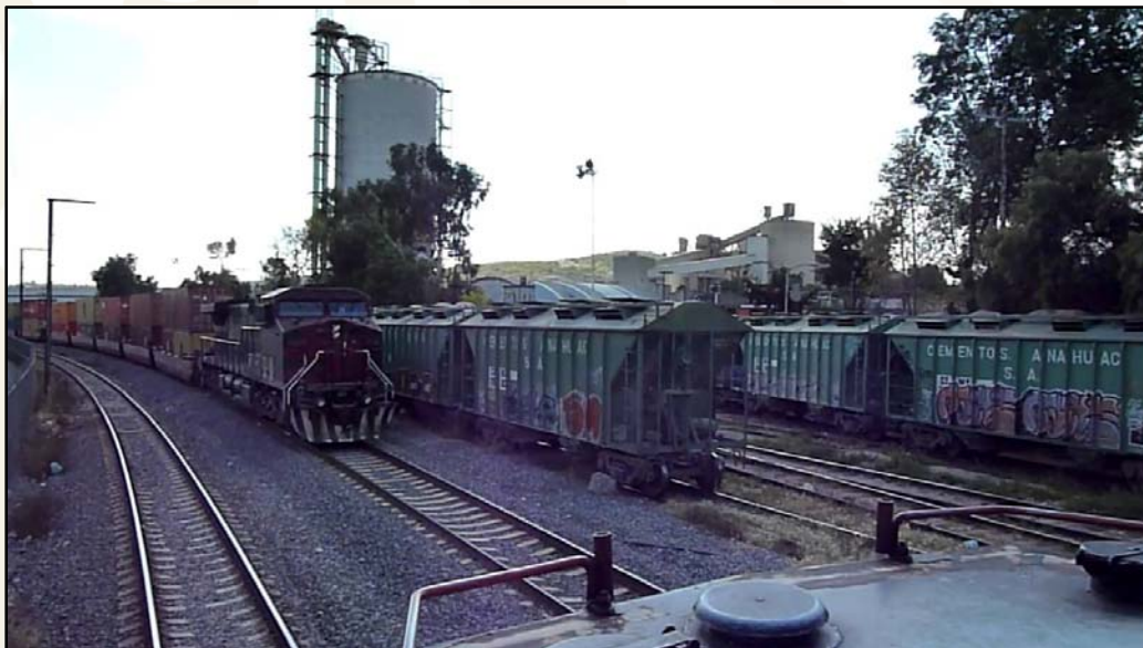
Planta CEMEX Barrientos, Vía Gustavo Baz No. 4500 San Pedro Barrientos municipio de Tlalneantla Estado de México (Foto: You Tobe)
