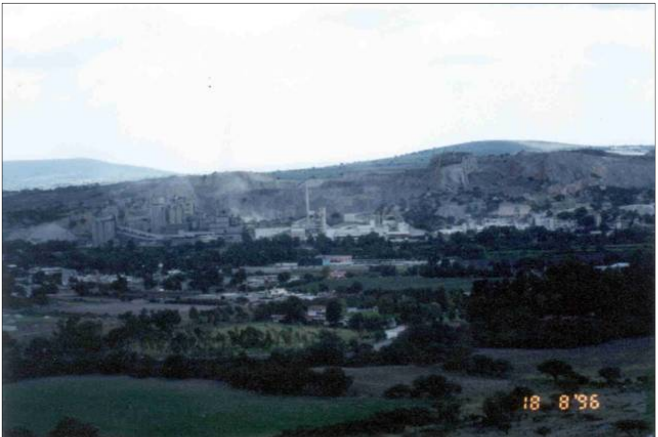
Vista general de la fábrica de Cementos Apasco, Mpio. de Apaxco, Edo. de México.
