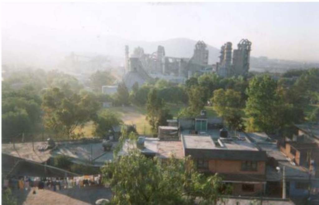
Planta CEMEX Barrientos, Vías Gustavo Baz No. 4500 San Pedro Barrientos Mpio. de Tlalnepantla, Estado de México.
