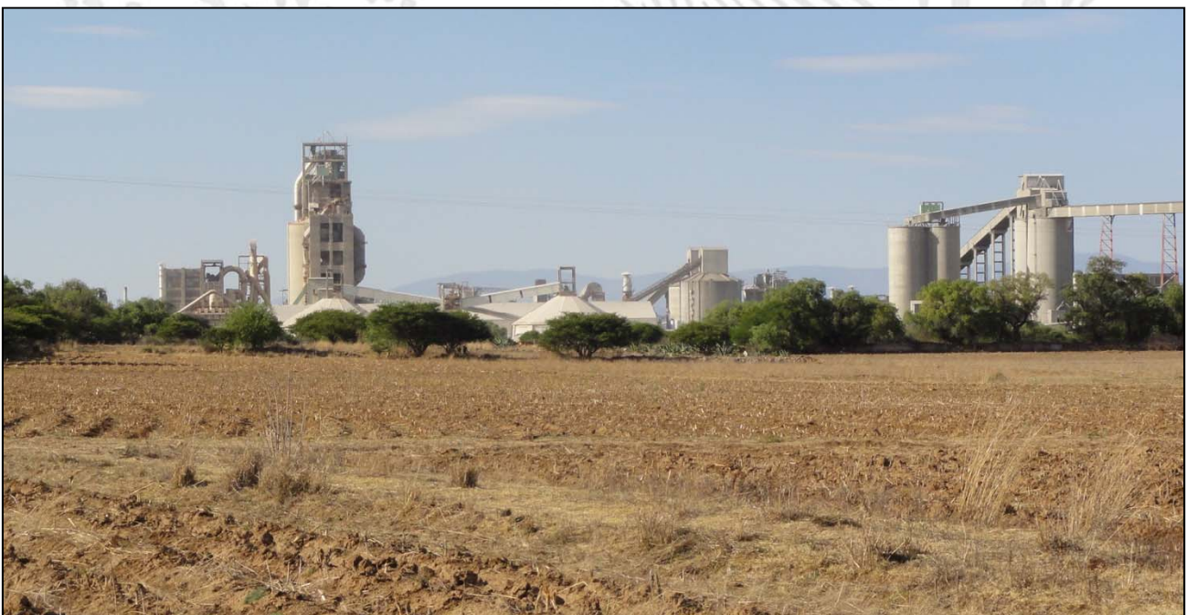
Planta Cementera de Cemex, S.A. de C.V., en Huichapan
