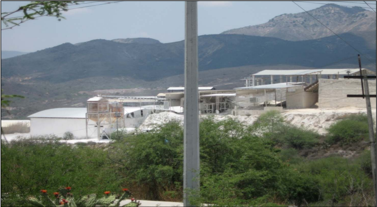
Planta trituradora de la Cementera Cemex, en Tula de Allende
