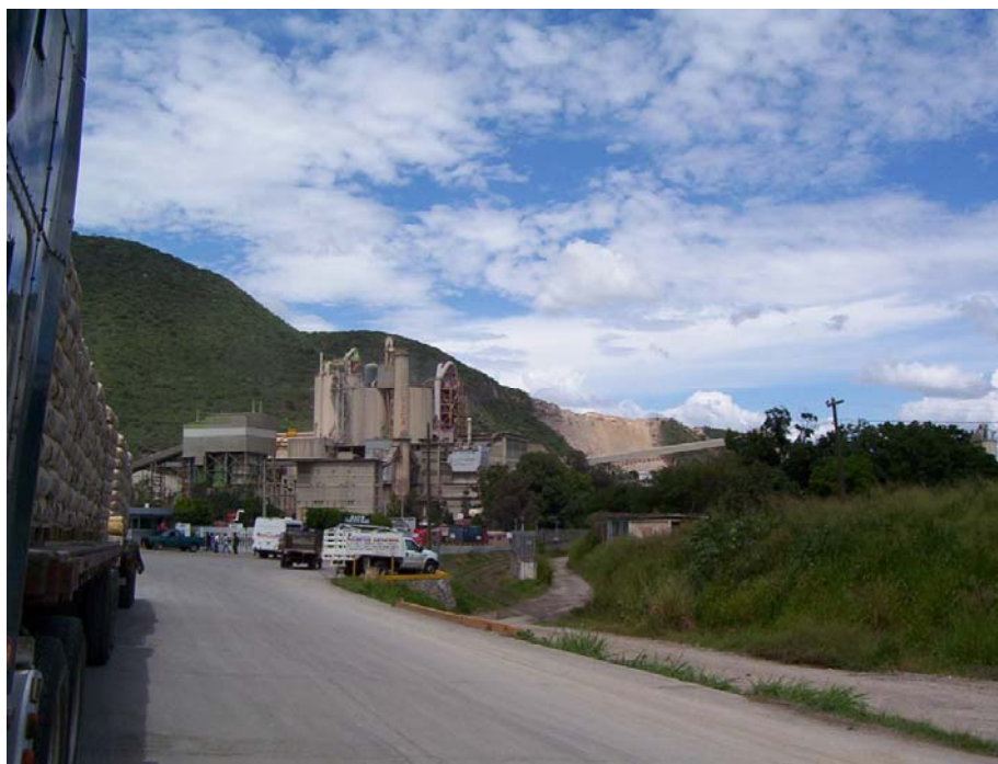
Otra vista, planta de cemento Tolteca, produce 1,500 toneladas día, municipio. de Zapotiltic Jal
