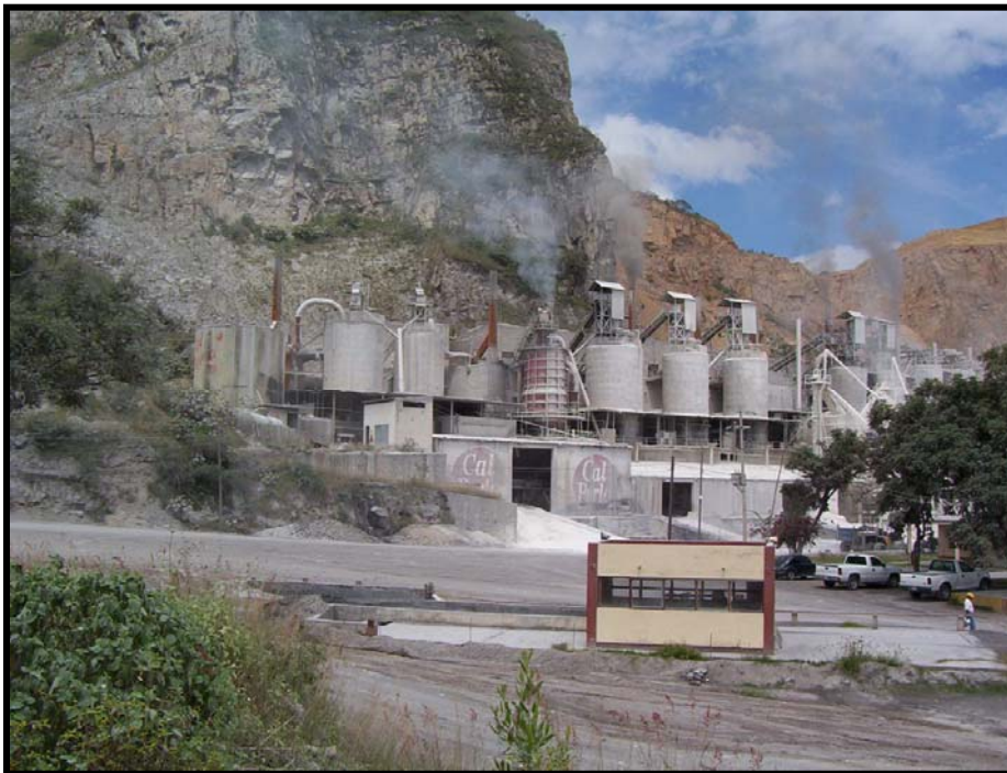
Vista general planta cal Perla, produce 1,000 toneladas día, Mpio. de Zapotiltic Jal.
