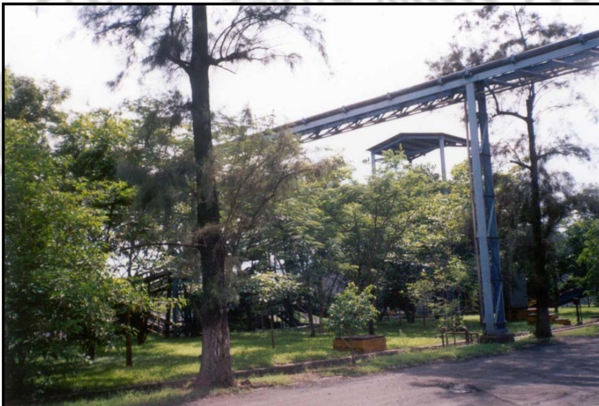
Banda transportadora dentro de la planta peletizadora de Estación Alzada, municipio de Cuauhtémoc, Col.
