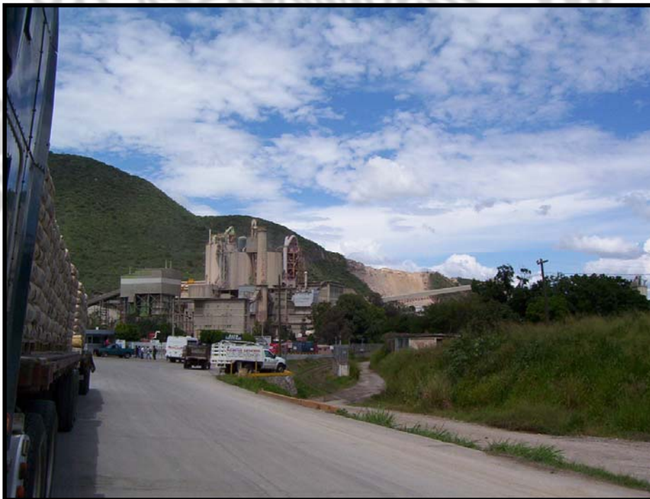
Otra vista, planta de cemento Tolteca, Zapotiltic, Jal.
