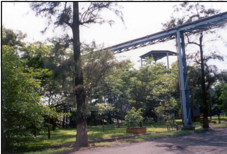
Banda transportadora dentro de la planta peletizadora de Estación Alzada, municipio de Cuauhtémoc, Col.
