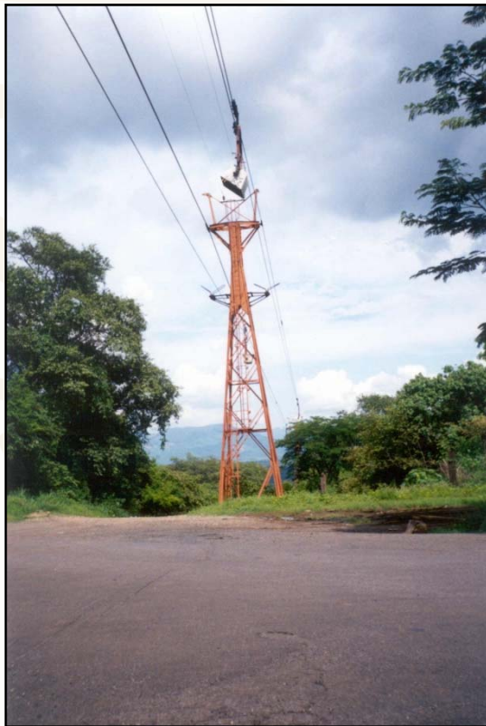
Teleférico que transporta el mineral de la mina El Encino a la planta peletizadora de estación alzada, Mpio. de Cuauhtémoc, Col.
