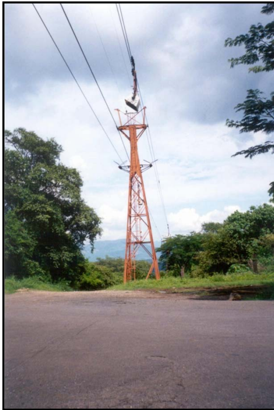
Teleférico que transporta el mineral de la mina El Encino a la planta peletizadora de estación Alzada, Mpio. de Cuauhtémoc, Col.
