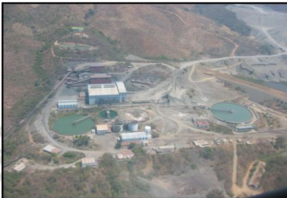
Planta de beneficio Las Truchas, municipio de Lázaro Cárdenas; Compañía Arcelor Mittal Steel.
