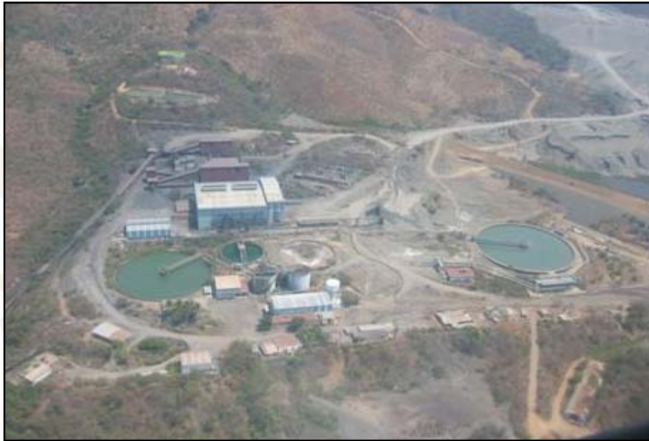
Planta de beneficio Las Truchas, municipio de Lázaro Cárdenas; Compañía Arcelor Mittal Steel.
