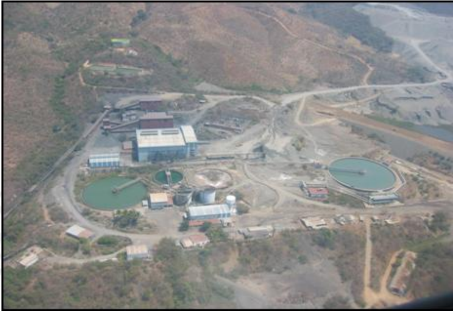
Planta de beneficio Las Truchas, Mpio. de Lázaro Cárdenas; Compañía Arcelor Mittal Steel.
