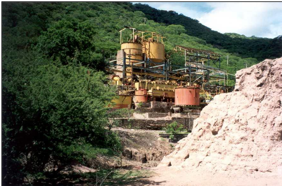
Fotografía 2. Instalaciones de la planta de concentración de la mina Santiago, en el distrito minero de Huautla.
