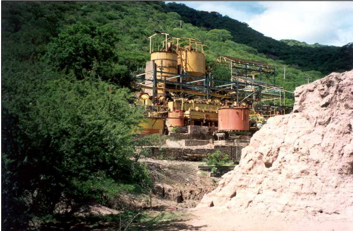
Instalaciones de la planta de concentración de la mina Santiago, en el distrito minero de Huautla.
