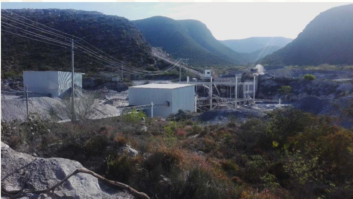
Texlamp, S.A. de C.V. Banco de explotación sobre calizas de la Fm. Aurora para agregados pétreos, mpio. de Villaldama, N.L.
