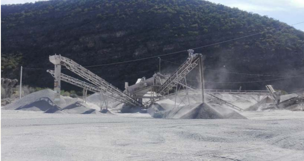
Panorámica de la planta de trituración y molienda de la empresa Paconsa, S.A. de C.V. ubicada en el mpio. de Villaldama., N.L.
