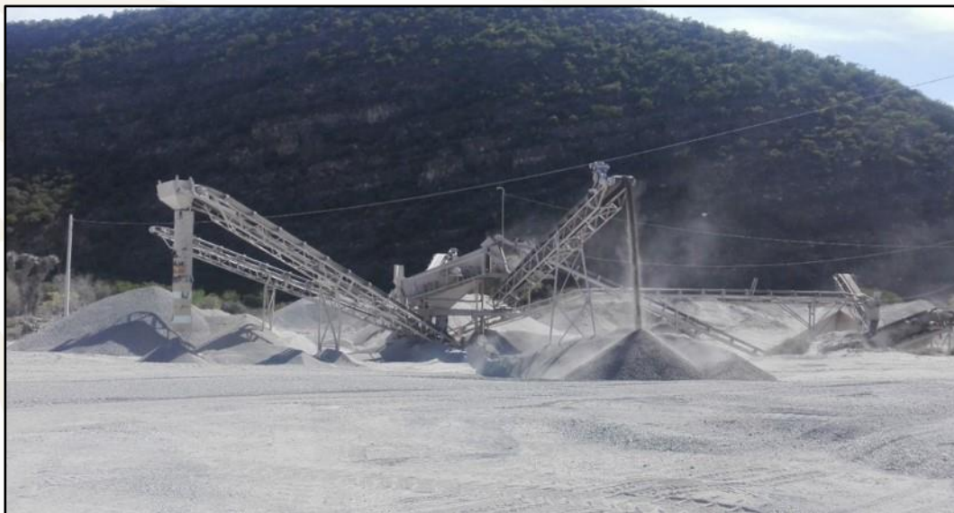
Panorámica de la planta de trituración y molienda de la empresa Paconsa, S.A. de C.V. ubicada en el Mpio. de Villaldama., N.L.
