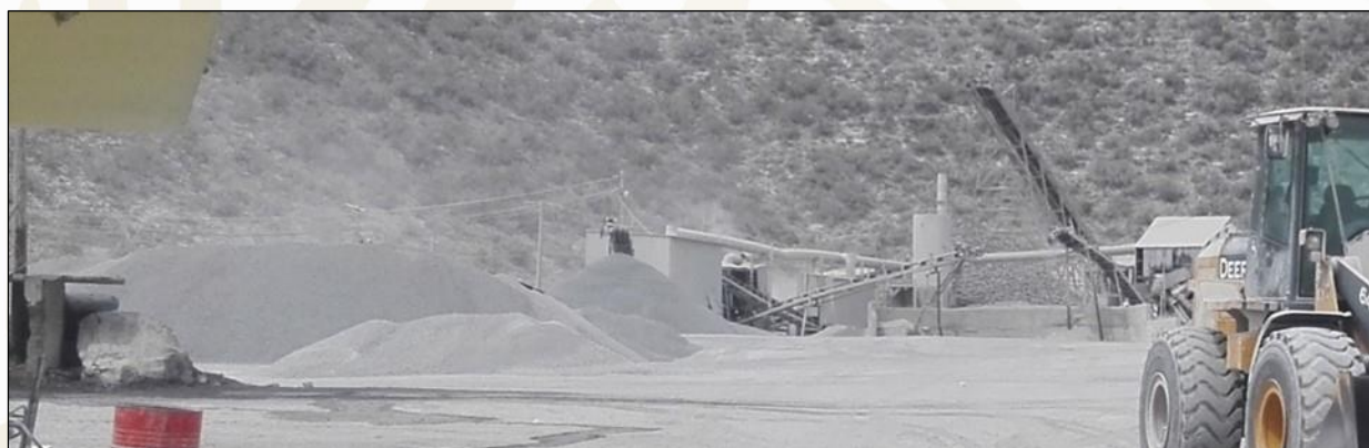
Panorámica de la planta de la empresa Industrializadora de Calizas del Norte S.A. de C.V., ubicada en el Mpio. de Villaldama, N.L.
