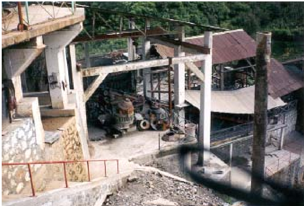
Planta de beneficio de la Compañía Minera Natividad y anexas, S. A. de C. V.
