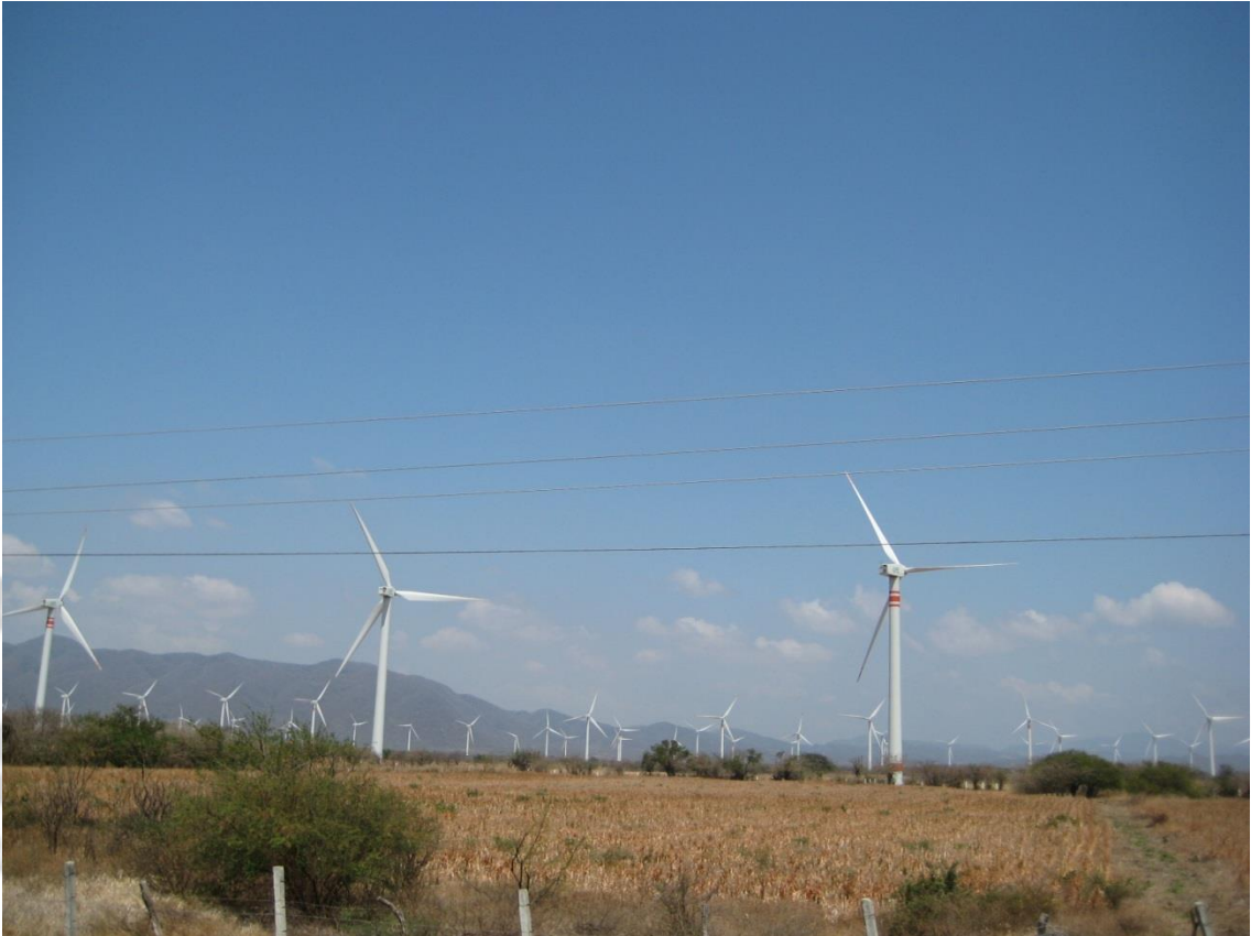
Generadoras de Energía Eólica en el Istmo de Tehuantepec, Oax.
