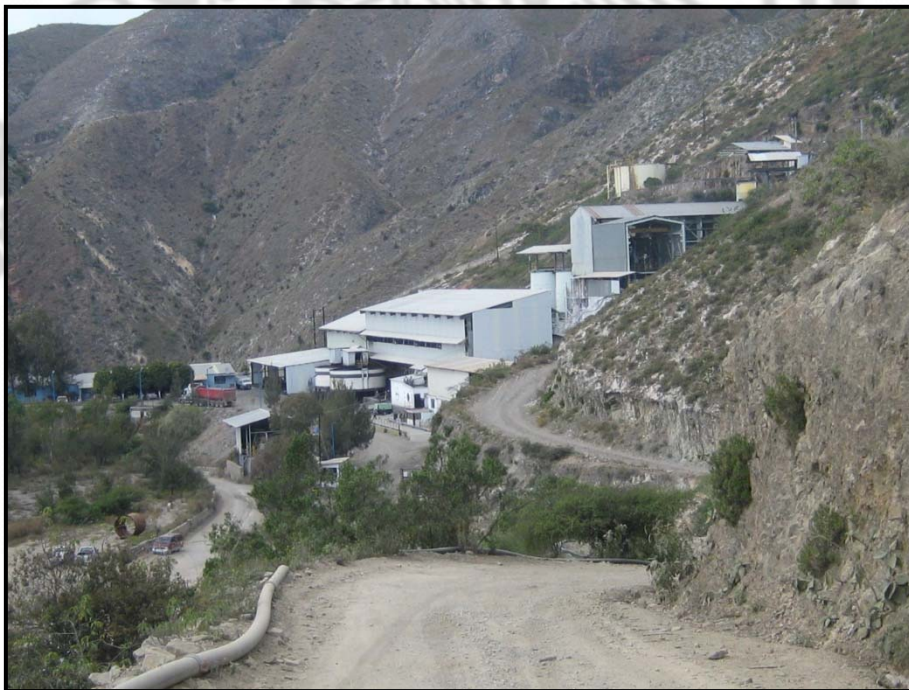
Otra vista de la planta de beneficio con capacidad para beneficiar 2000 t/día unidad minera La Negra, Maconí, municipio de Cadereyta, Qro.
