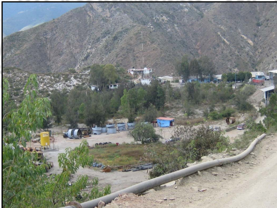
Instalaciones de la planta de beneficio en la unidad minera La Negra. Maconí, municipio de Cadereyta, Qro.
