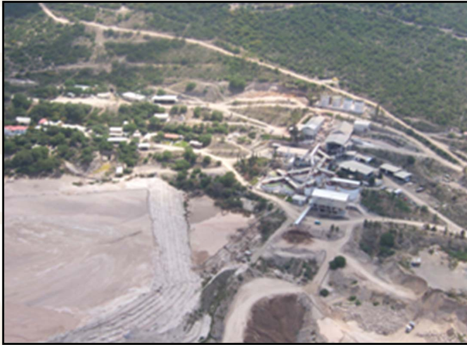
Panorámica de las instalaciones de la mina San Martín, en la región minera Bernal.
