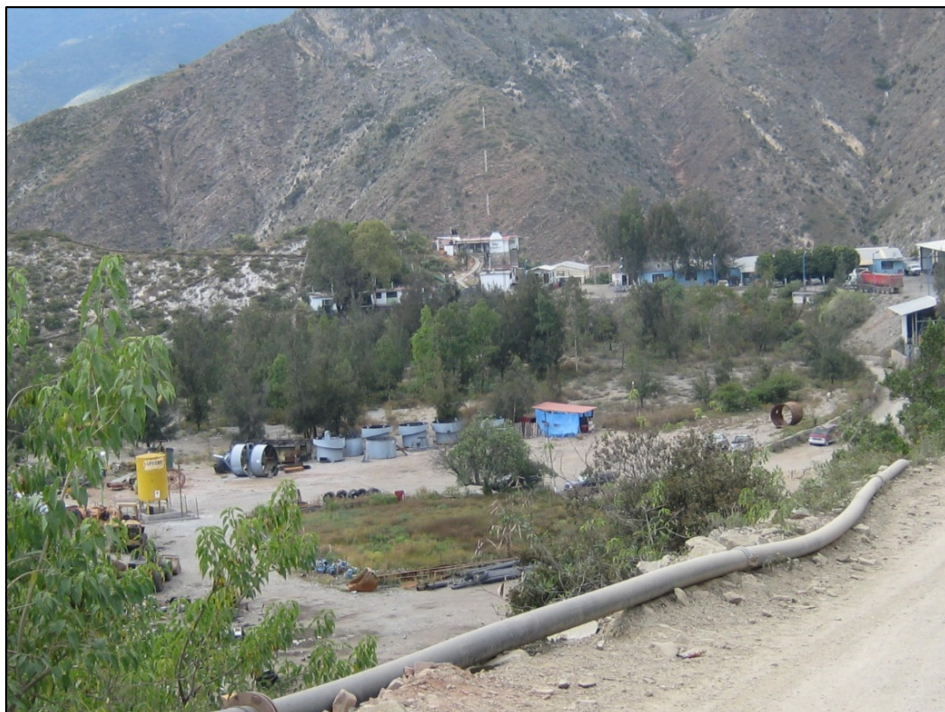
Instalaciones de la planta de beneficio en la unidad minera La Negra. Maconí, municipio de Cadereyta, Qro.
