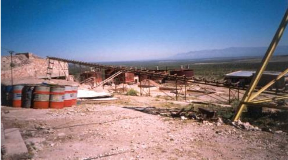
PLANTA DE FLOTACIÓN INACTIVA CINCO ESTRELLAS MUNICIPIO DE CHARCAS
