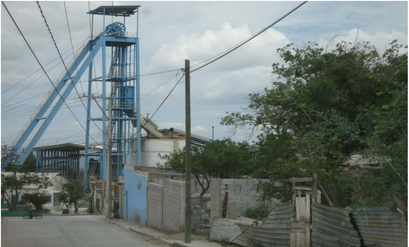
PLANTA DE TRITURACION DE NEGOCIACION MINERA STA. MARIA DE LA PAZ
