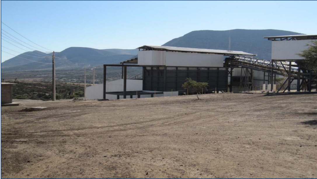
Vista panorámica Planta Cia. Impulsora Minera Santa Cruz, procesa Ag, Pb, Zn.
