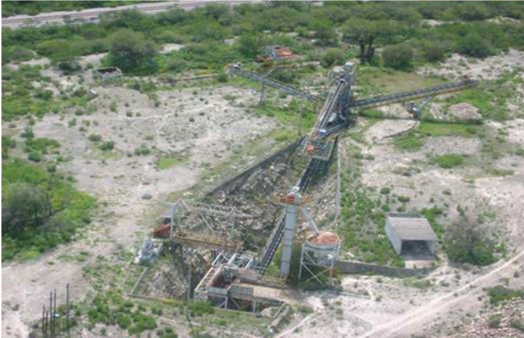
Planta procesadora de yeso La Borreguita, actualmente inactiva
