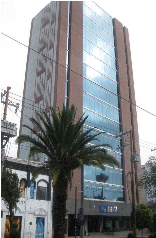
Edificio INEGI Informes y ventas planta baja
