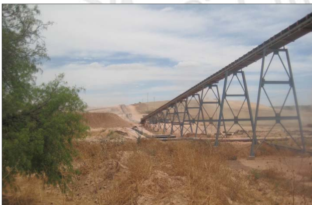
Bandas Transportadoras de material de mina del tajo a las camas de lixiviación
