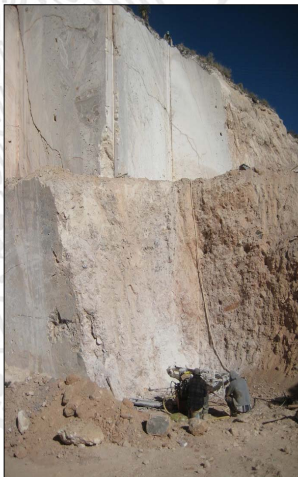
Maquina barrenando, para luego introducir el hilo diamantado para el corte del bloque.
