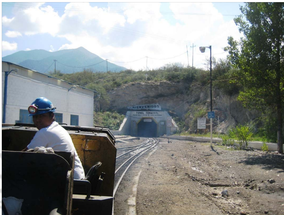
Acceso a la mina Tayahua, por el túnel Terminal (Distrito Minero Providencia)
