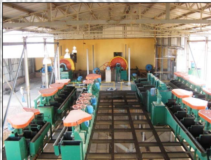
Área de Flotación
