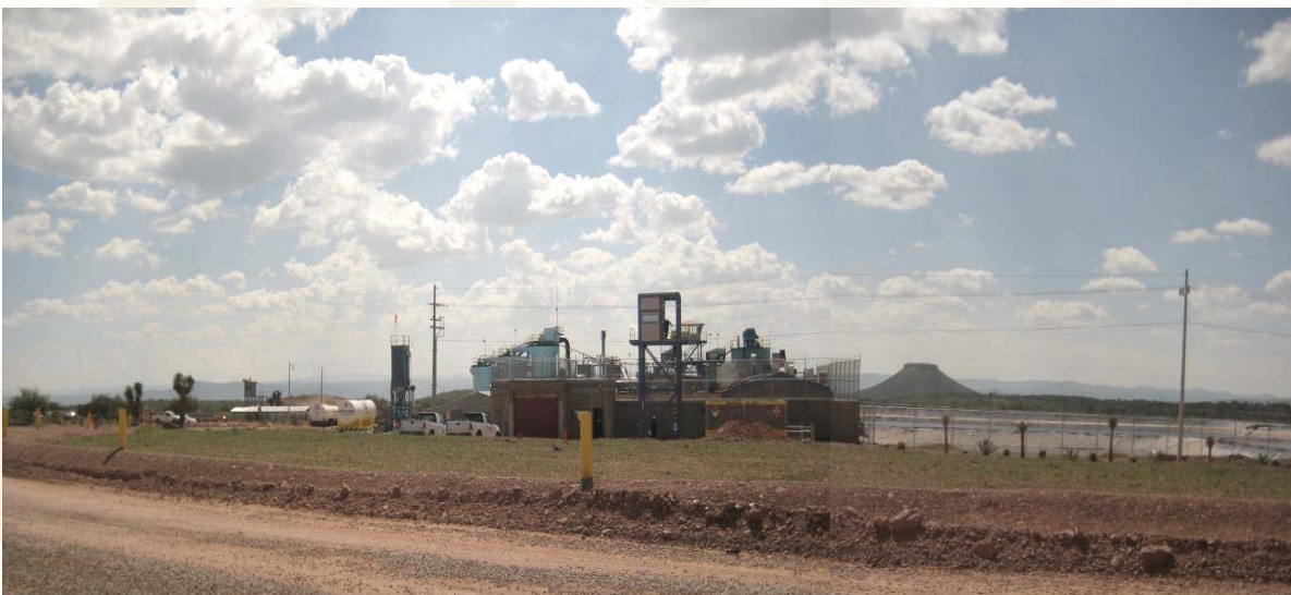
Compañía Minera Frisco, S.A. de C.V. (Unidad El Coronel) Planta de Beneficio ADR-Adsorción, Despojo y Refinación (Como producto final se tienen Barras de Dore de 20 y 22 kg con: 85% de Au, 15 % de Ag).
