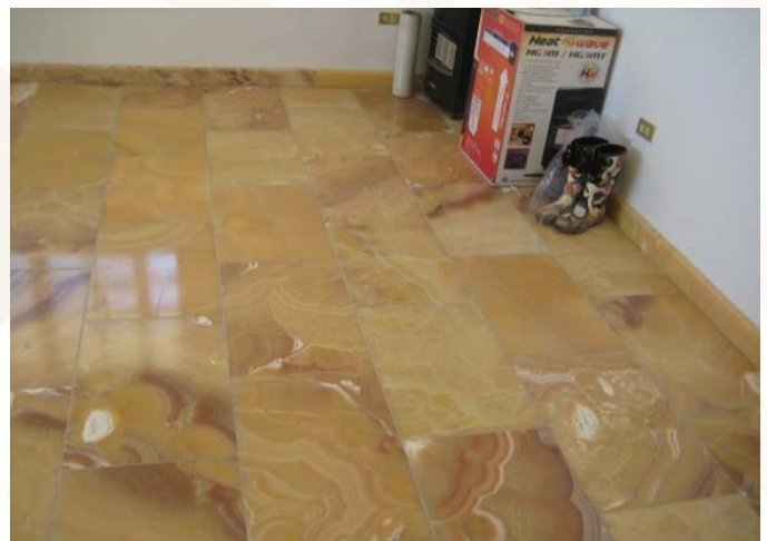
Detalle del producto final de Ónix en piso, pero también se utiliza como parquet, muebles de baño y artesanías.
