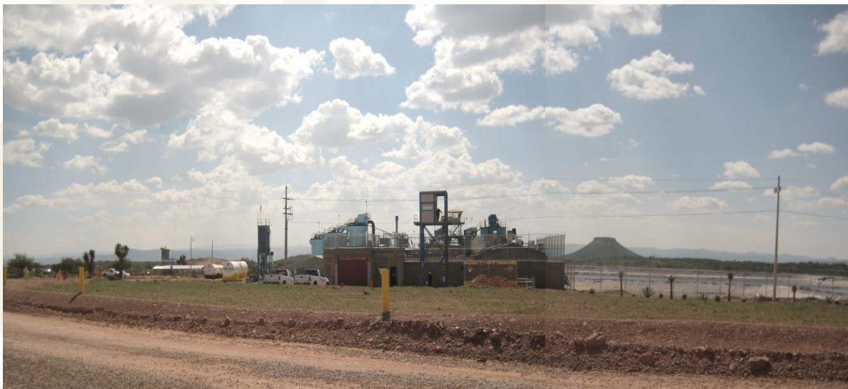
Compañía Minera Frisco, S.A. de C.V. (Unidad El Coronel) Planta de Beneficio ADR-Adsorción, Despojo y Refinación (Como producto final se tienen Barras de Dore de 20 y 22 kg con: 85% de Au, 15 % de Ag).
