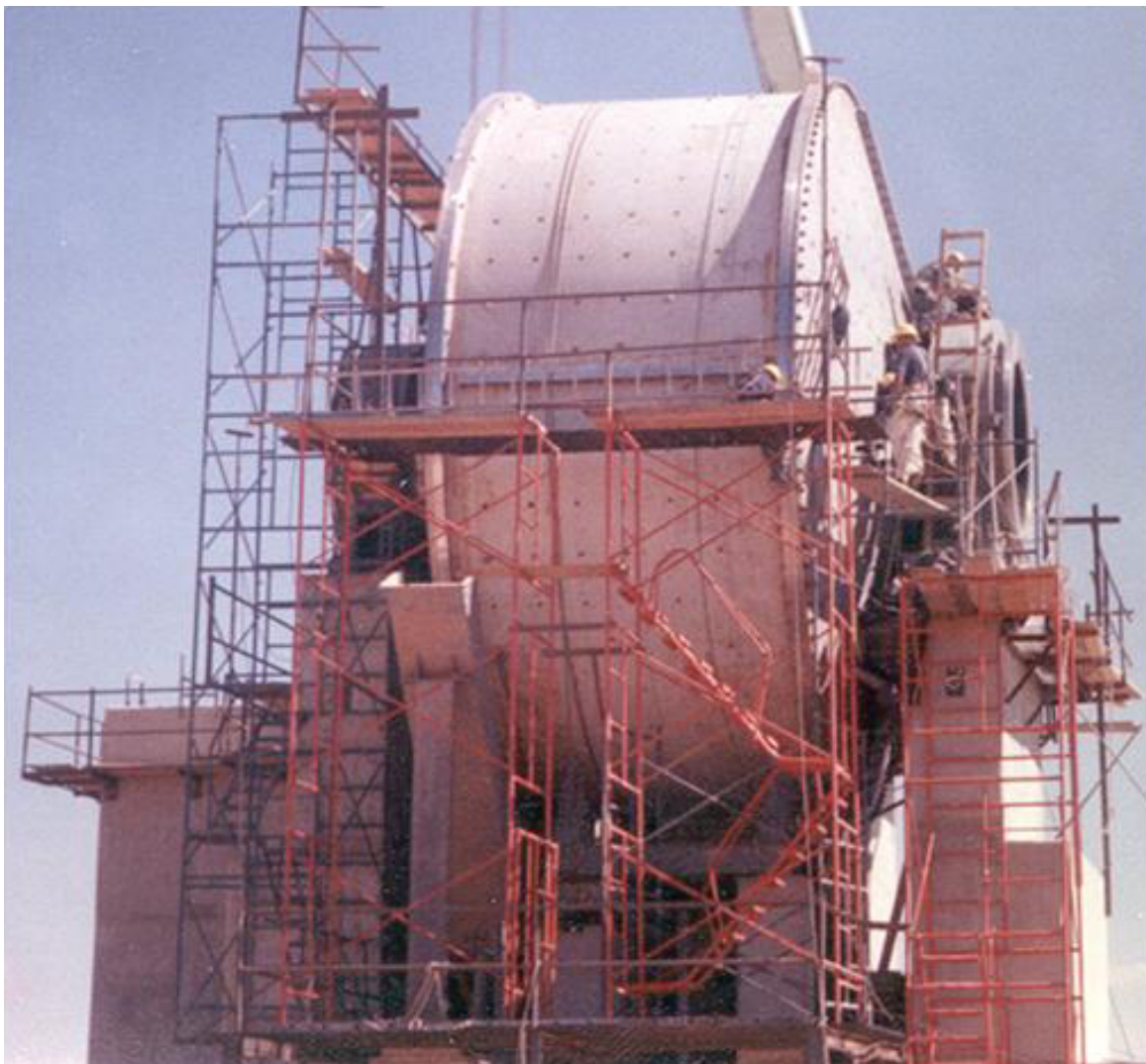
Molino de la Planta Francisco I. Madero, Zac.
