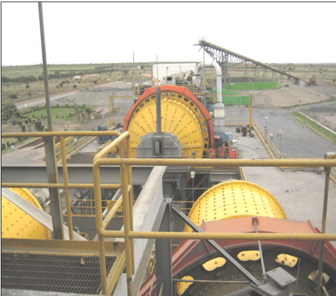
Molino de la Planta Francisco I. Madero, Compañía minera Peñoles, S.A. de C.V.
